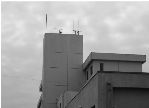
図2 Web用カメラ（学生寮屋上）
